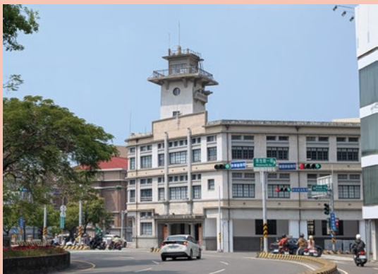
▲臺南市消防史料館(臺南市中西區中正路 2-1 號)
