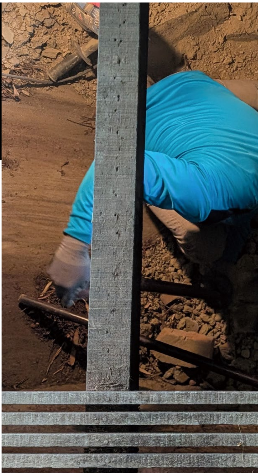
▲ 今年 0125 地震震央位於臺南東山區，導致東山多數龍眼焙灶毀損，圖中工人正在修繕焙灶 / 陳文彥
