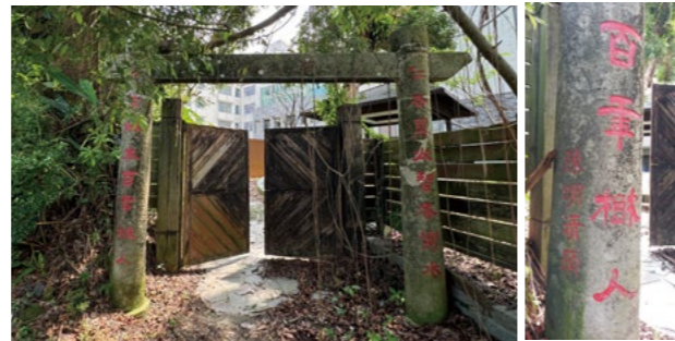
▲「春風」、「化雨」牌坊設置在關嶺國小舊址(現在的嶺頂公園)，「化雨」牌坊因施工不慎而毀壞重建，僅存「春風」牌坊保持原貌
