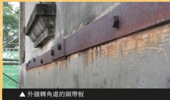
▲ 頤樓磚牆原補強 U 型鋼棒取出後以不鏽鋼抽換
