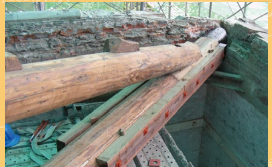
▲ 屋架大樑新舊料連接部位以台持繼手接續並於側面增加添板對接
