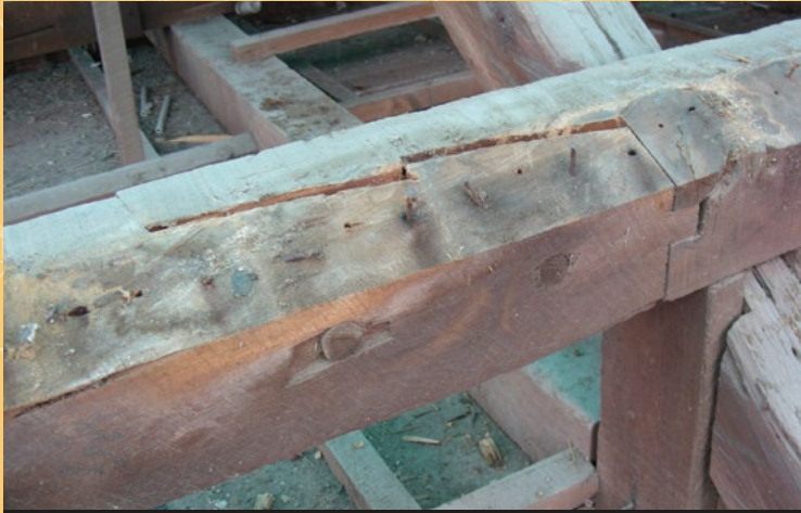
▲ 簷廊軸組框架使用「追掛繼手」與「金輪繼手」的前身——「布繼」接續
